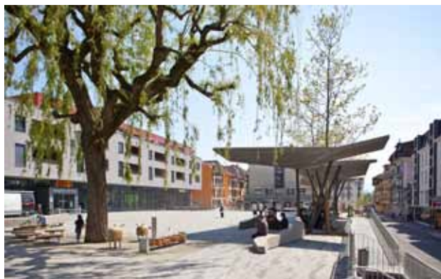
SDOL : réaménagement de la place du Marché à Renens (Paysage et Local architecture, 2011)
