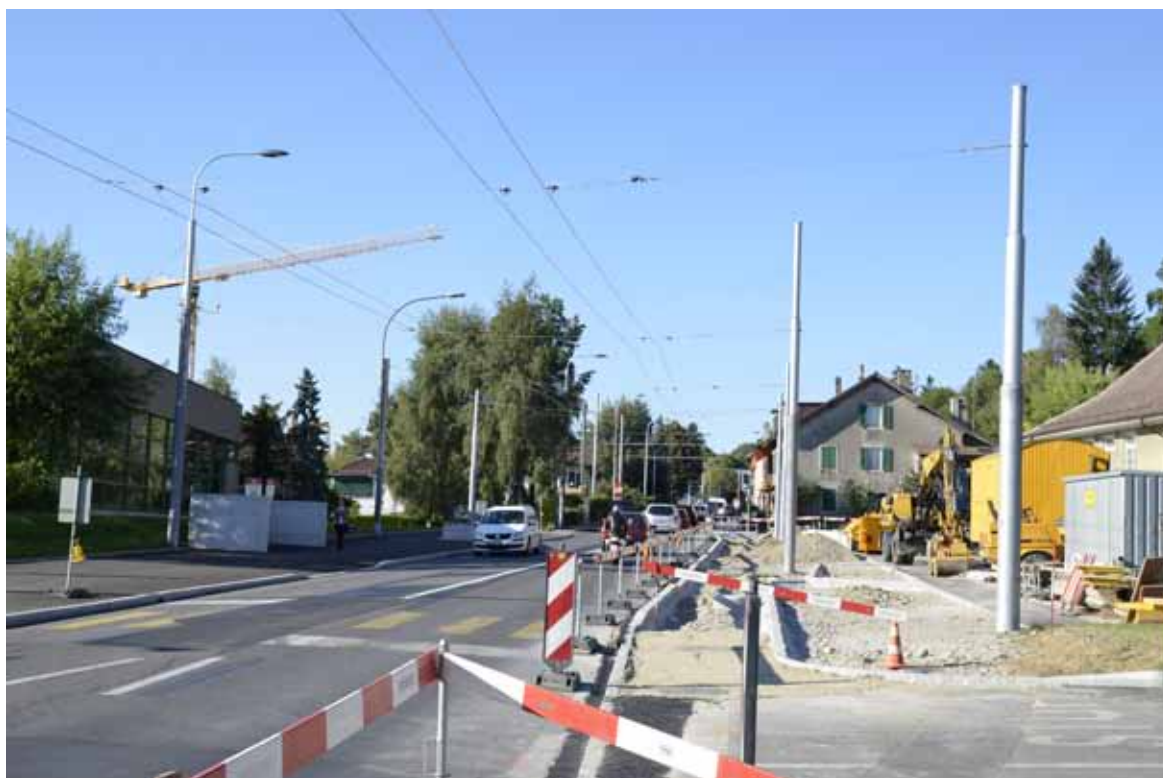
SDNL : construction des nouveaux arrêts de bus de la ligne 8 au Mont-sur-Lausanne (2011)
