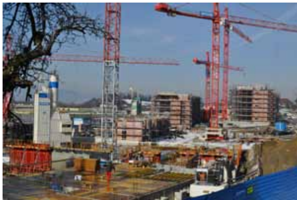
SDNL : le quartier du Rionzi en construction
