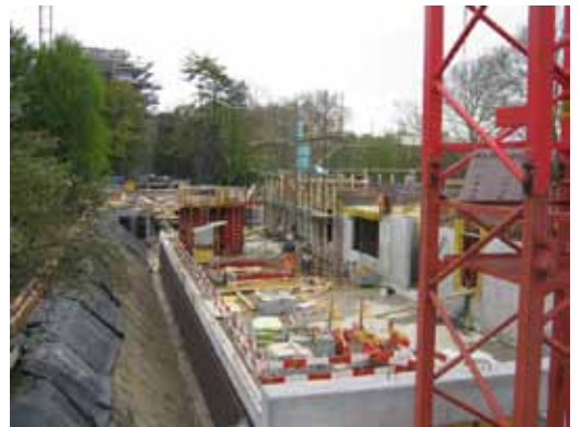
SDRM : le quartier En-Bonjean en construction
