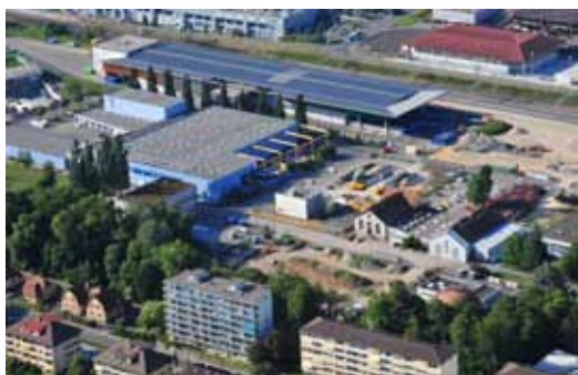
SDOL : centre intercommunal de logistique et de déchetterie. (photo Joël Christin, 2012)
